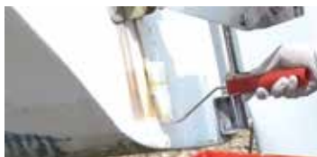
Appliquer au pinceau ou au rouleau Apply with a paint brush or a roller
